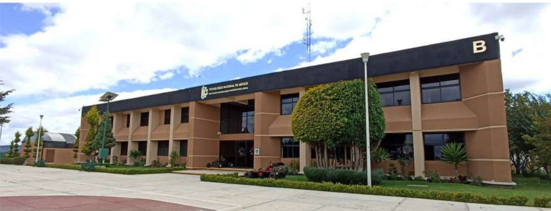
UNIDAD ACADÉMICA DEPARTAMENTAL . EDIFICIO B
