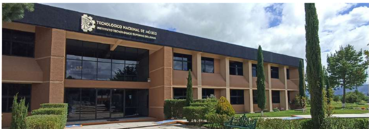
UNIDAD ACADÉMICA DEPARTAMENTAL. EDIFICIO I
