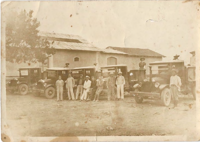
Imagen 9: Trabajos de ampliación del camino Zaragoza-Zacapoaxtla-Cuetzalan, capitán Tomás Molina (derecha), c. 1920. Fuente: AHPFMB.
